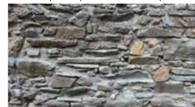
Fig. 15. Mur en moellons Source : A4PLUSA
