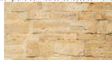
Fig. 16. Mur en pierres de taille Source : A4PLUSA
