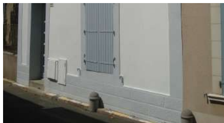
Fig. 63. Soubassement en mortier
