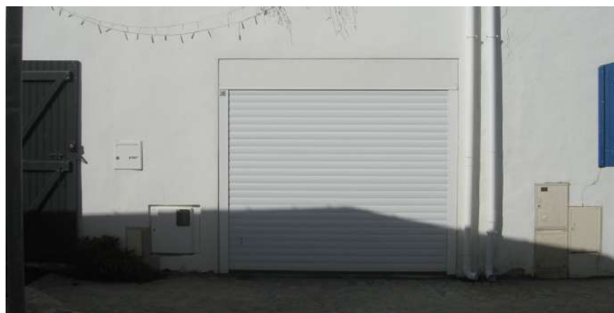
Fig. 81. 16 rue Anatole France, porte parking PVC
