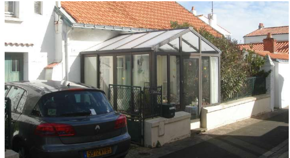
Fig. 84. 4 rue Jean Ingoult, veranda visible de l'espace public
