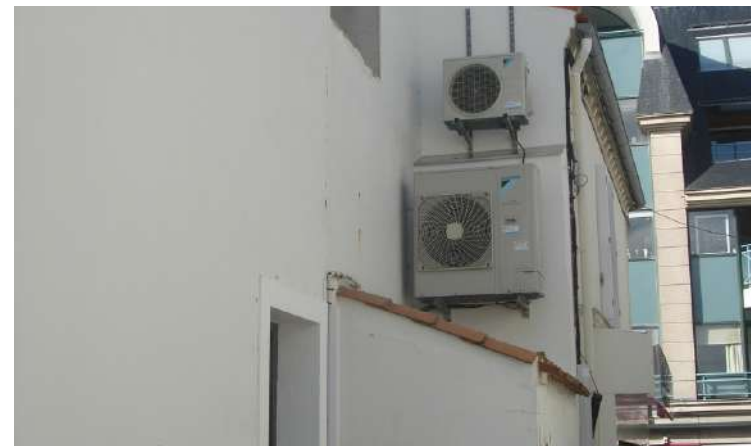
Fig. 85. Rue de la Petite Ile, caissons visibles de l'espace public
